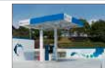
③福岡アオモト水素ステーション (宮若市四郎丸)
