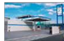
⑤Dr. Driveセルフ福岡空港店 水素ステーション (糟屋郡志免町別府北)
