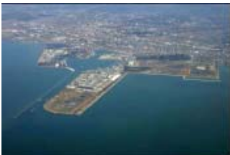
岸壁の長さが340mで1万トン級の大型船が2隻同時に接岸可能な三池港
